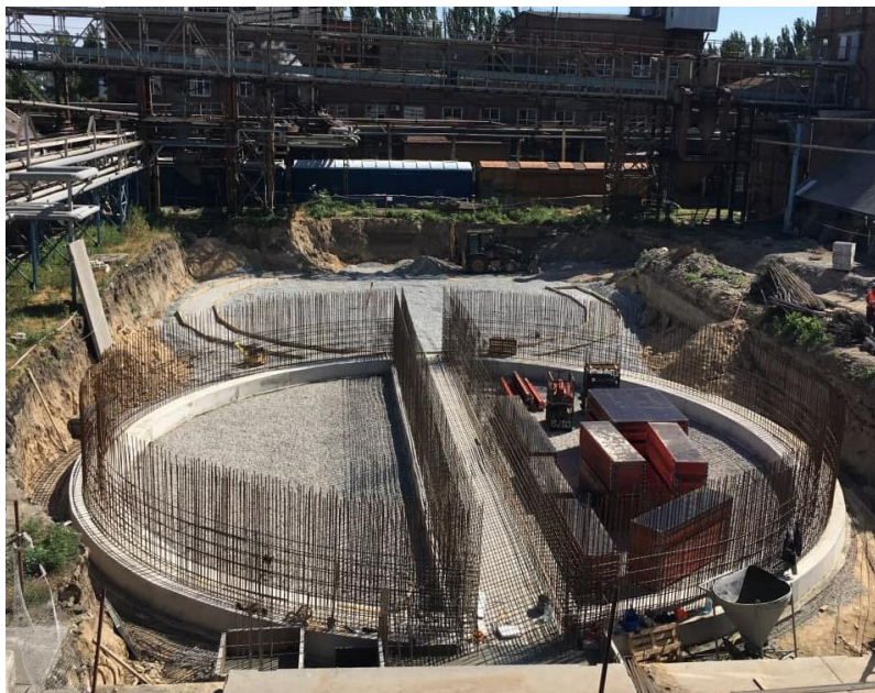
Рис. 1 Фундамент силосу з підземною галереєю на етапі будівництва
