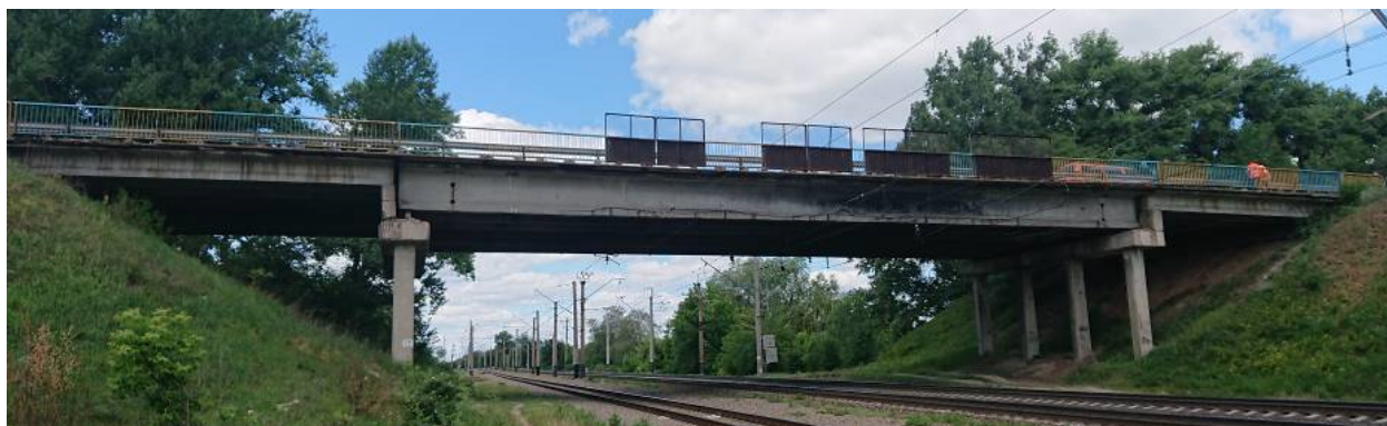
Рис. 1. Загальний вид шляхопроводу зі сторони Харкова
