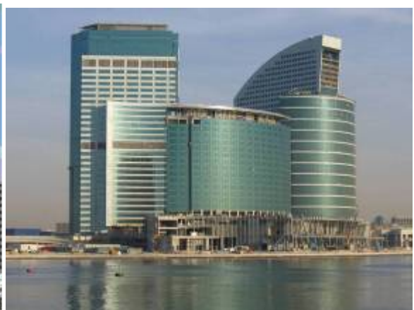
Рис.2. Застосування постнапруження за технологією фірми VSL. Дубай, ОАЕ (фестивальне містечко). Загальна площа постнапруження 250 тис.м 2
