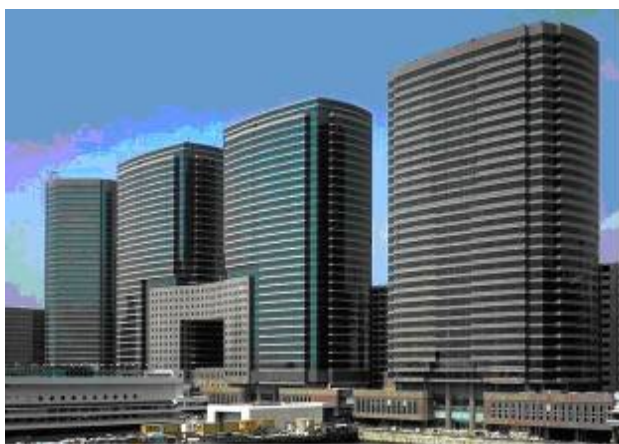
Рис.1. Застосування постнапруження за технологією фірми VSL. Гонконг, Китай
