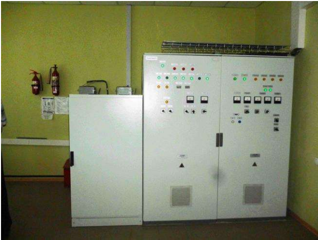
Рис. 7. Стойка питания СП-2 (справа)
