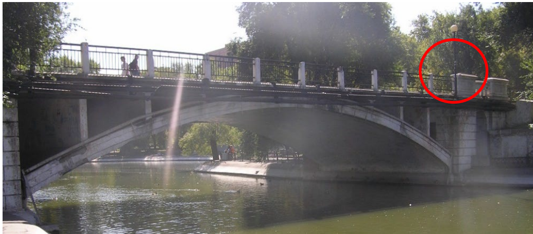
Рис. 1. Загальний вид пішохідного арочного мосту у Центральному міському дитячому парку Лазаря Глоби у м. Дніпро
