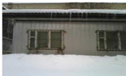
Рис.2. Здание сборное из «сендвич» панелей
