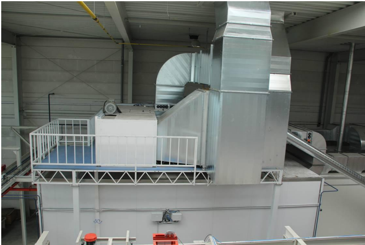
Рис. 3.6. Система підготовки повітря для фарбувальної камери
