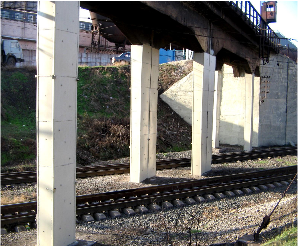
Рисунок 4 – Відремонтовані стояки шляхопроводу за допомогою металоін'єкційної обойми
