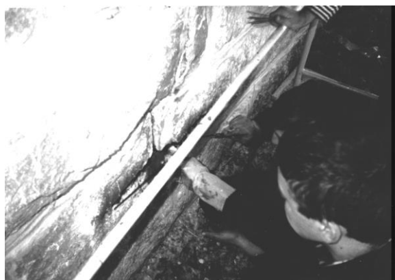
Рисунок 3 – Встановлення високоміцного дроту у пропил
