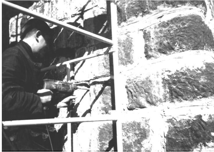
Рисунок1 – Глибока розшивка швів за допомогою перфоратора
