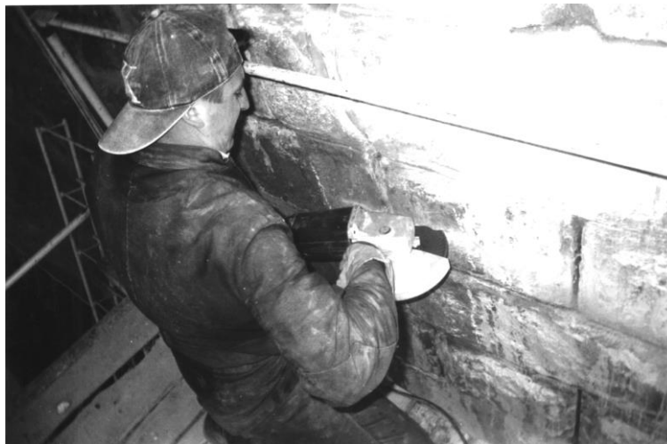
Рисунок 2 – Виконання пропилів у каменях кутовою шліфувальною машиною
