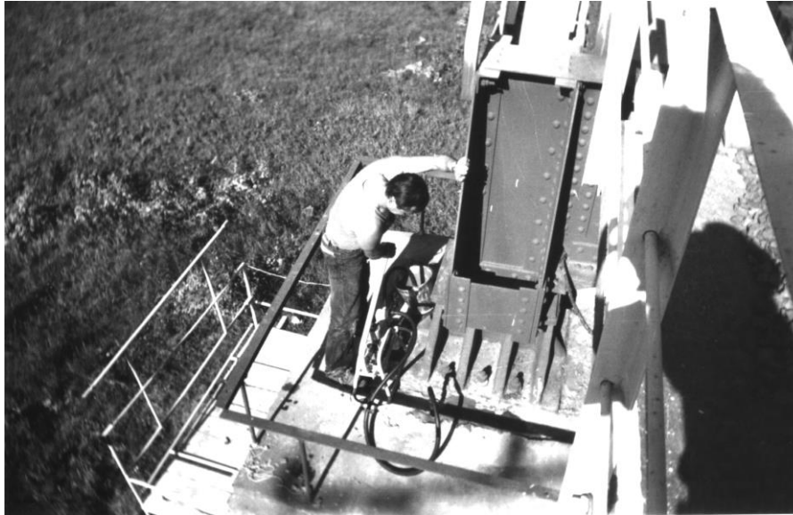
Рисунок 6 – Нагнітання СПЦВС за допомогою ручного насоса
