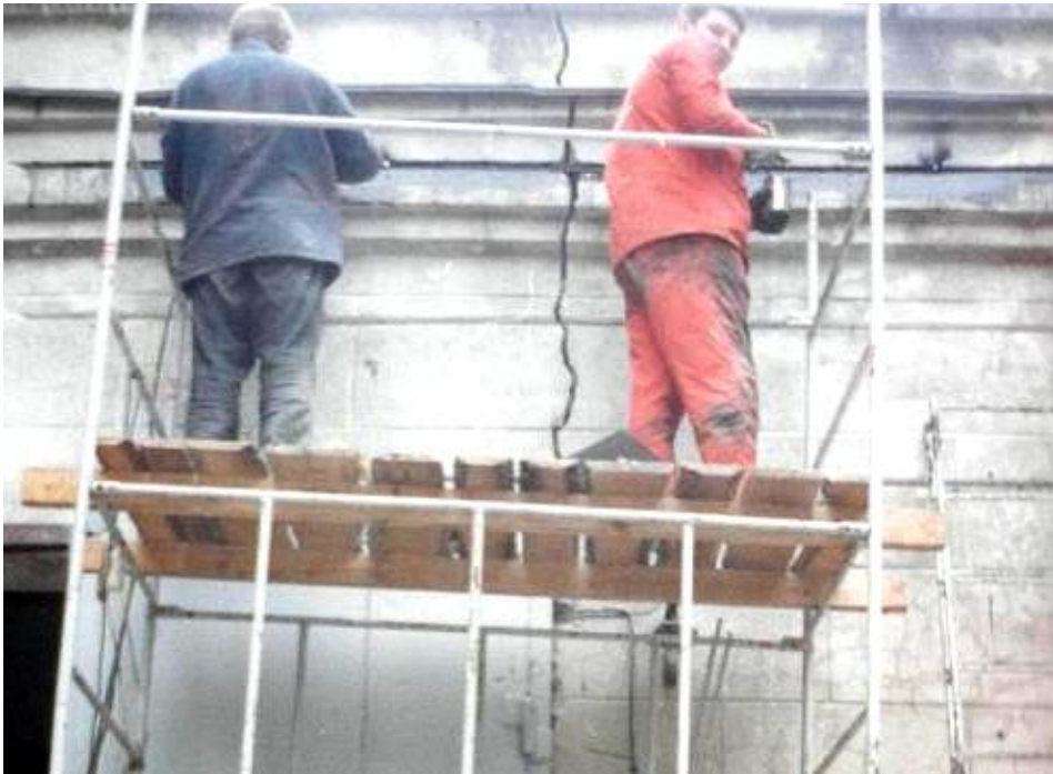
Рисунок 7 – Виконання пропилів у конструкції
