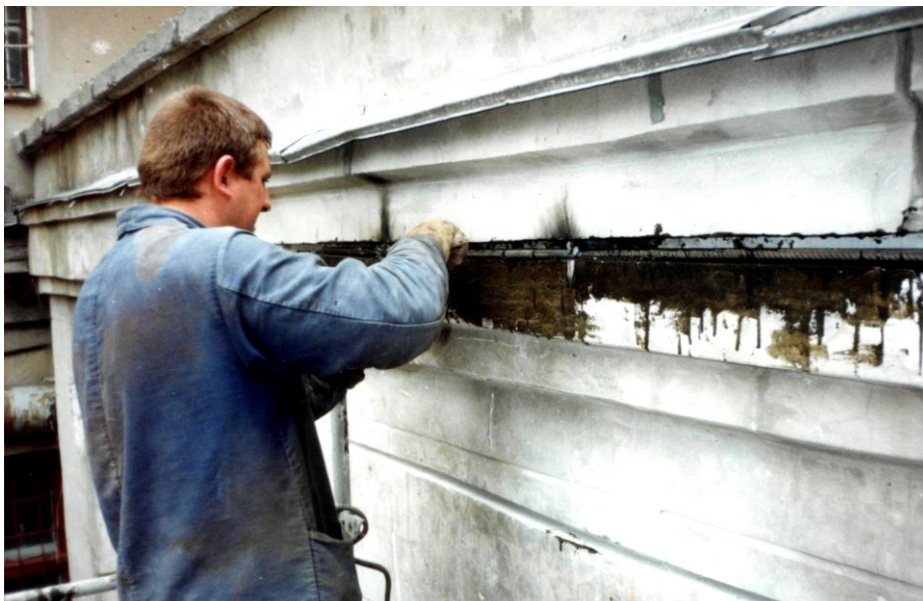
Рисунок 8 – Встановлення арматурних стрижнів у пропили
