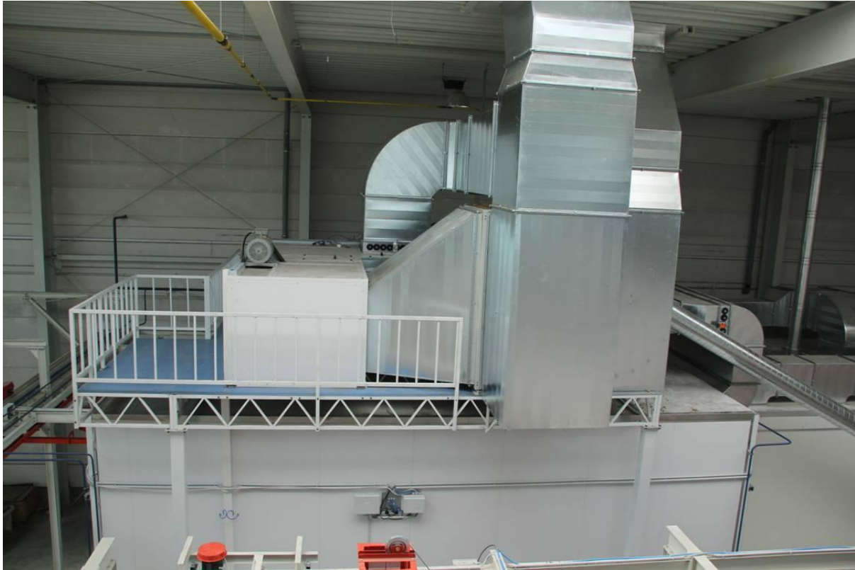
Рисунок 6 – Система підготовки повітря для фарбувальної камери
