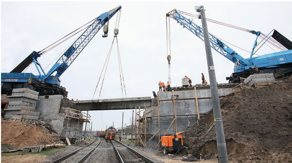
Рис. 5.1. Крани ЕДК-2000 (ліворуч) і ЕДК-500 (праворуч) на будівельно-монтажних роботах
