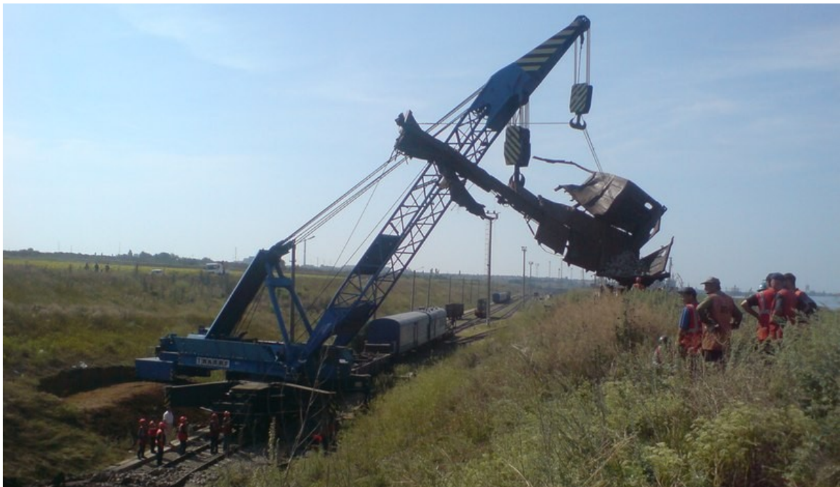
Рис. 5.2. Кран ЕДК-2000 на аварійно-відновлювальних роботах
