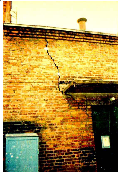
Рис. 7. Вигин будівлі сушарки піску локомотивного депо Основа Південної залізниці внаслідок нерівномірного завантаження основи (будівля різновисока з окремими фундаментами важкого устаткування всередині):
