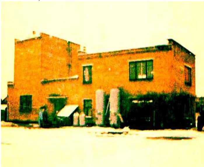
Рис. 7. Вигин будівлі сушарки піску локомотивного депо Основа Південної залізниці внаслідок нерівномірного завантаження основи (будівля різновисока з окремими фундаментами важкого устаткування всередині):
