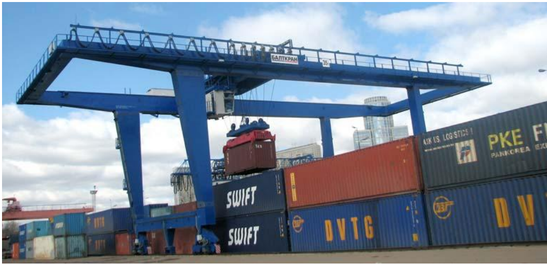
Рис. 3.22. Контейнерний термінал на ТСК з порталним контейнероперевантажувачем (УДЦТС «Ліски»)
