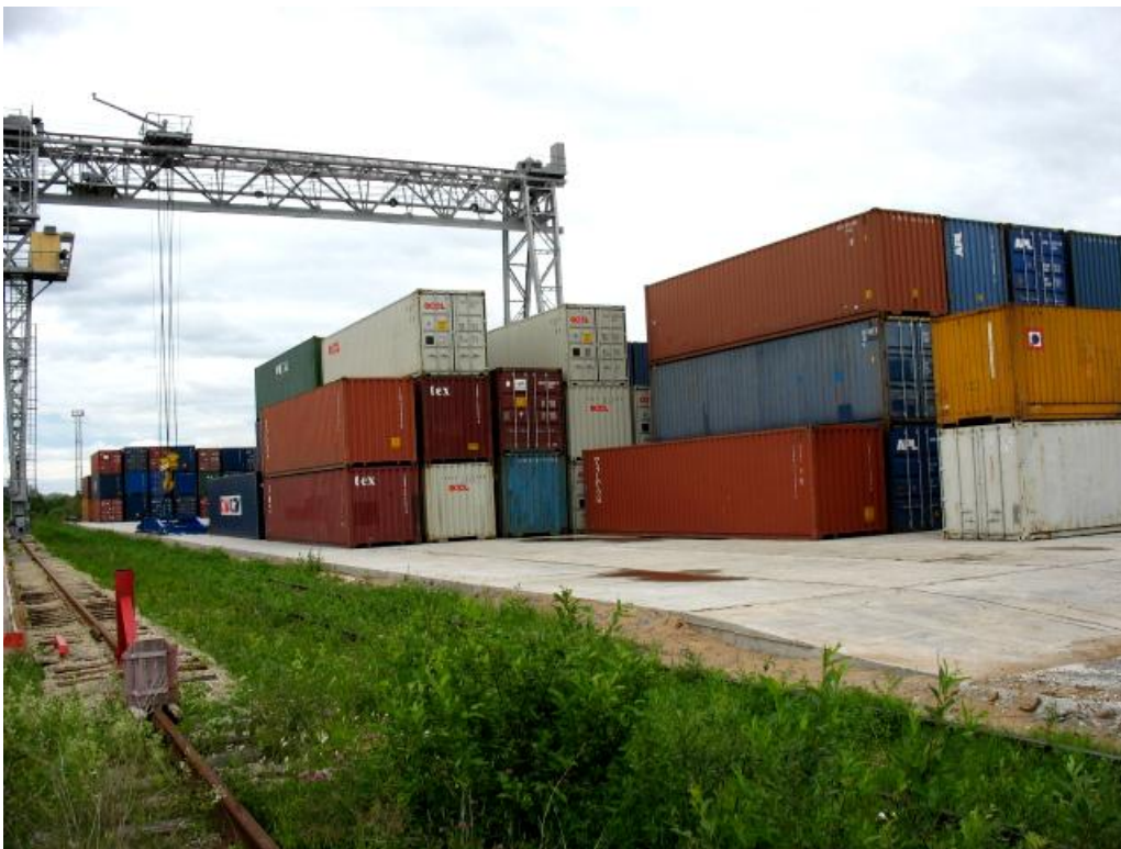
Рис. 1.2. Термінал великотоннажних контейнерів
