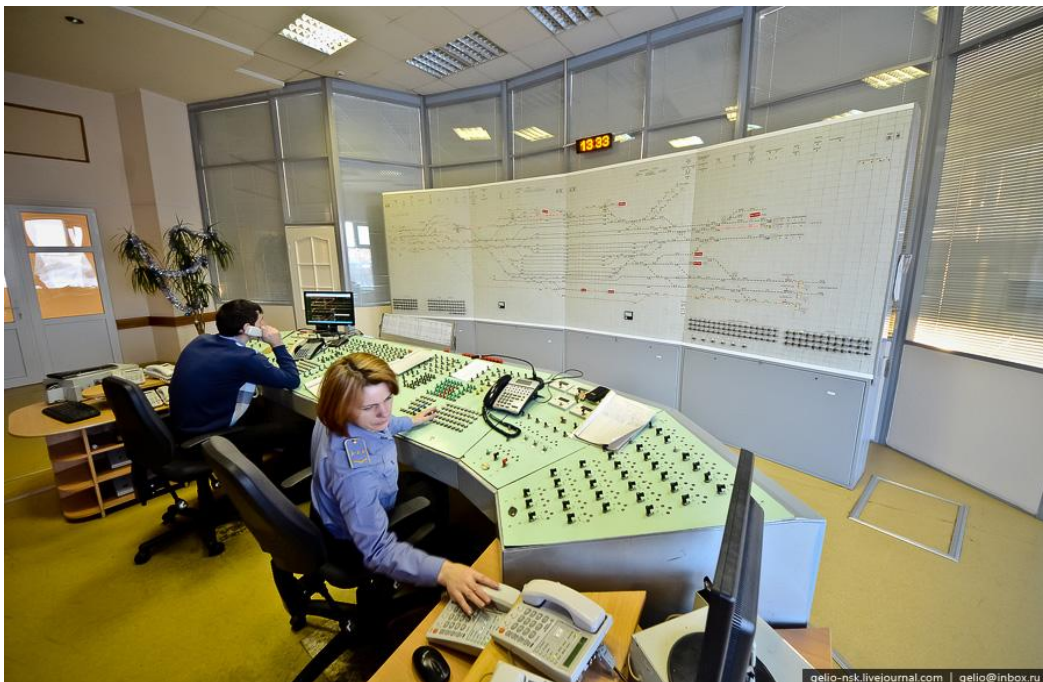
Рис. 5.2. Приміщення чергового по сортувальній станції Основа
