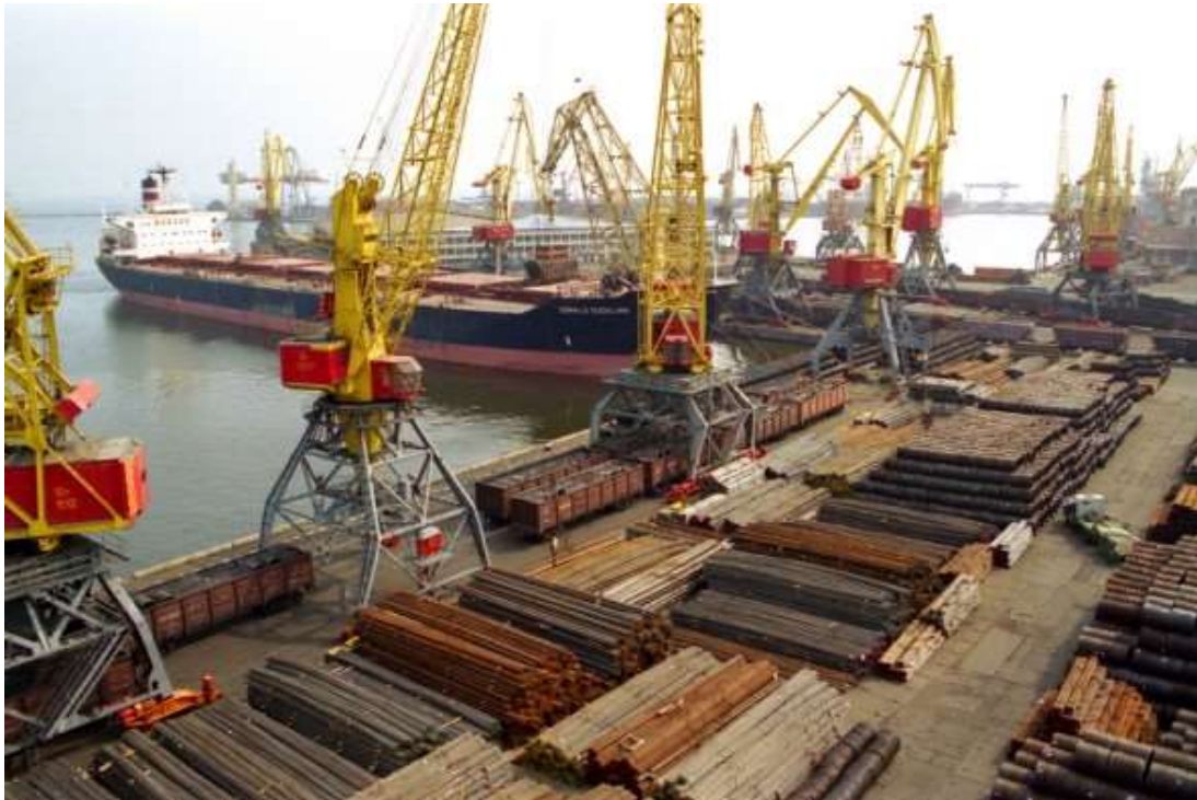
Рис. 23.1. Термінал в Одеському морському порту з перевантаження металопродукції. Площа території: 141 г. Кількість причалів: 54. Протяжність причальної лінії: більше 9000 м. Максимальні параметри суден, що приймаються: довжина – до 330 м, ширина – до 40 м, осадка – до 13,0 м
