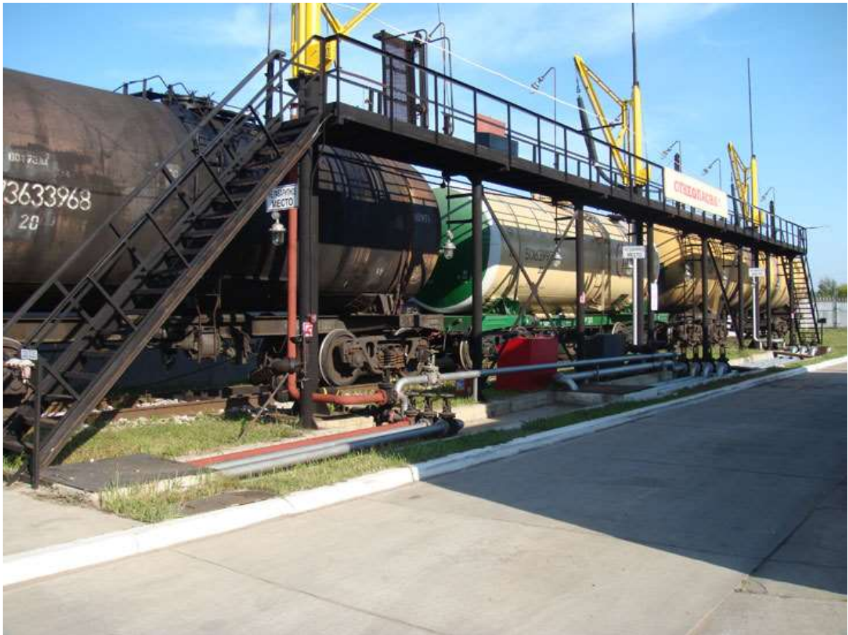
Рис. 5.6. Злив нафтопродуктів на нафтобазі з улаштуванням естакади для зливу
