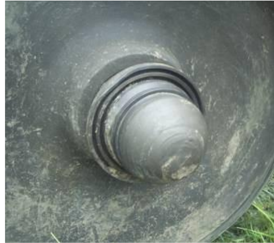
Рис. 4.78. Злам шийки осі через руйнування буксового вузла
