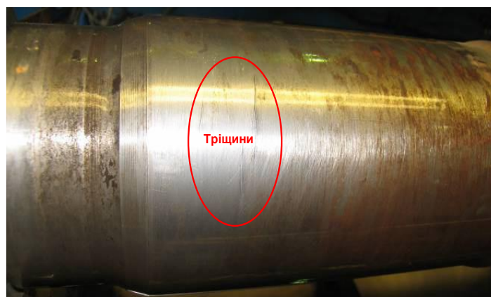
Рис. 4.46. Тріщини в підматочинній частині осі
