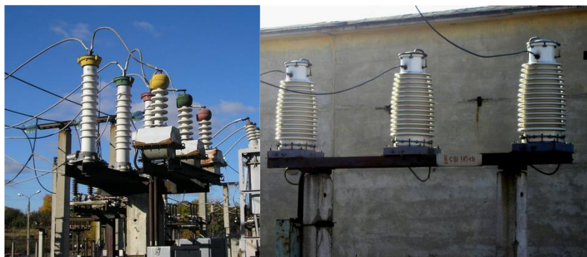
Рис. 13.6. Зовнішній вигляд трансформаторів напруги ЗНОМ-35 і НКФ-110
