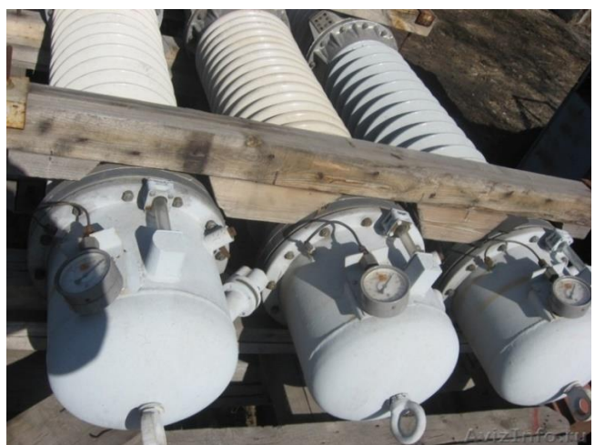
Рис. 14.6. Вимикач ВМТ-110
