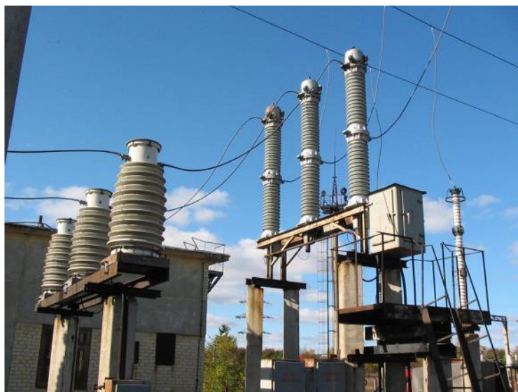
Рис. 13.10. Зовнішній вигляд маломасляного вимикача ВМТ-110 (справа) і трансформатора струму ТФЗМ-110 (зліва)
