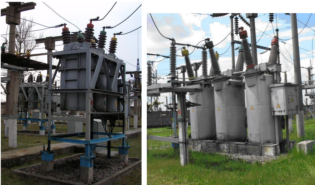
Рис. 14.3. Фото масляних вимикачів С-35 і У-110
