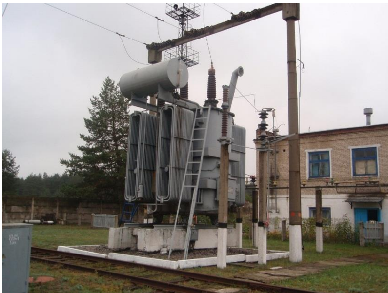
Рис. 2.5. Трансформатор підстанції
