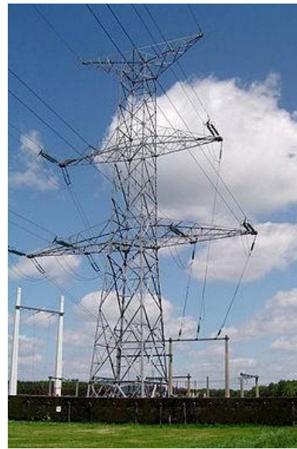
Рис. 3.3. Види опор ЛЕП: а – проміжна; б – анкерна кінцева
