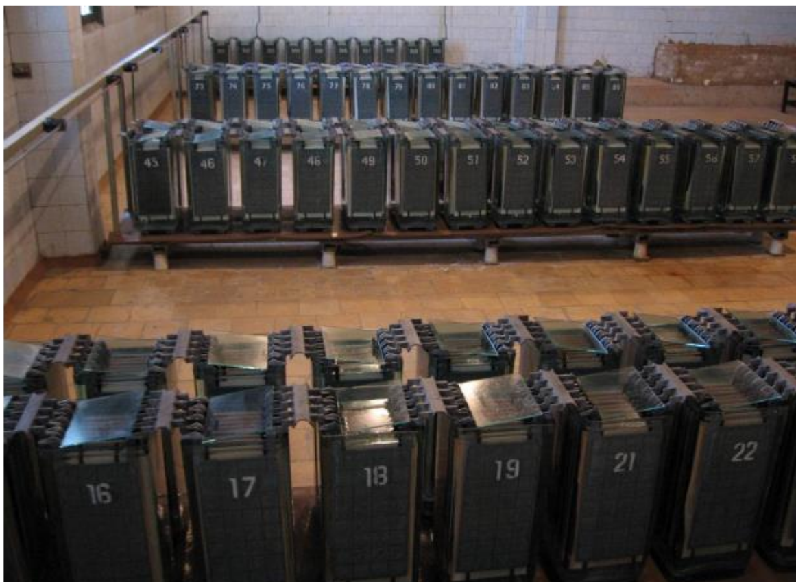
Рис. 22.4. Свинцево-кислотні акумулятори
