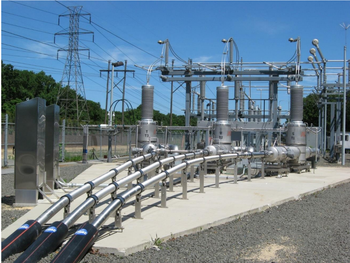
Рис. 23.15. Три однофазних надпровідних кабелі і вводи в кріогенну частину на задньому плані проекту LIPA в США, кожен зі струмом 2400 А і напругою 138 кВ, загальною потужністю 574 МВт
