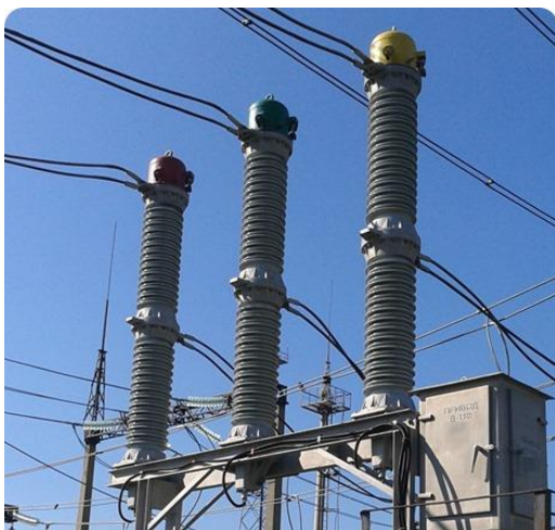
Рис. 14.6. Вимикач ВМТ-110
