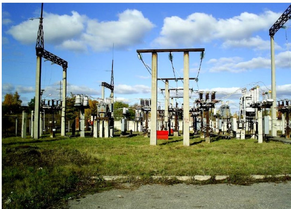
Рис.11.7. Розподільний пристрій 35 кВ
