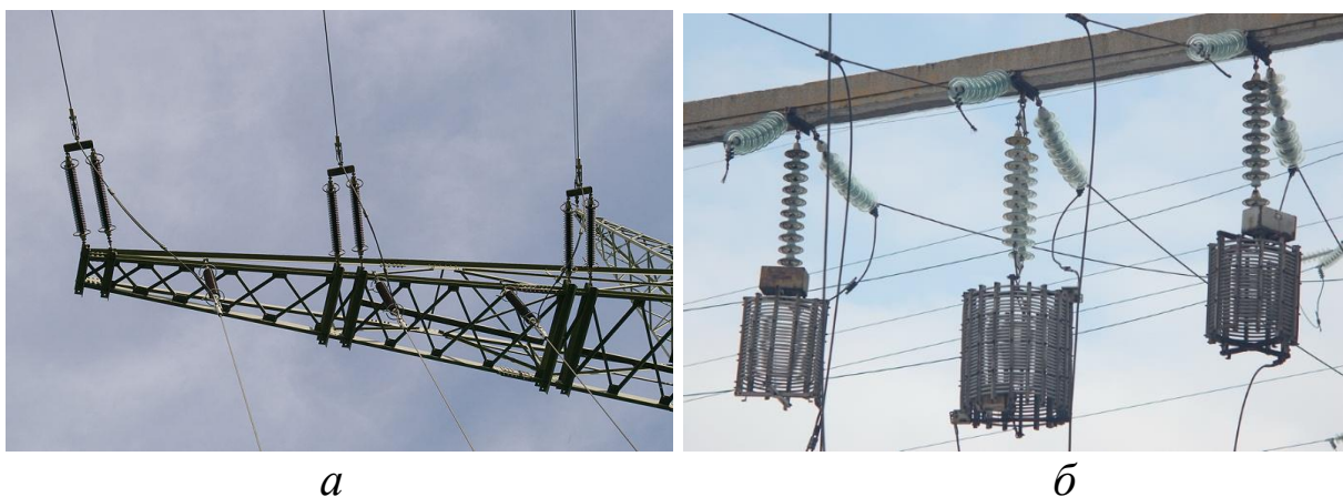
Рис. 3.9. Елементи ЛЕП: траверса (а) і ВЧ-загороджувачі (б)
