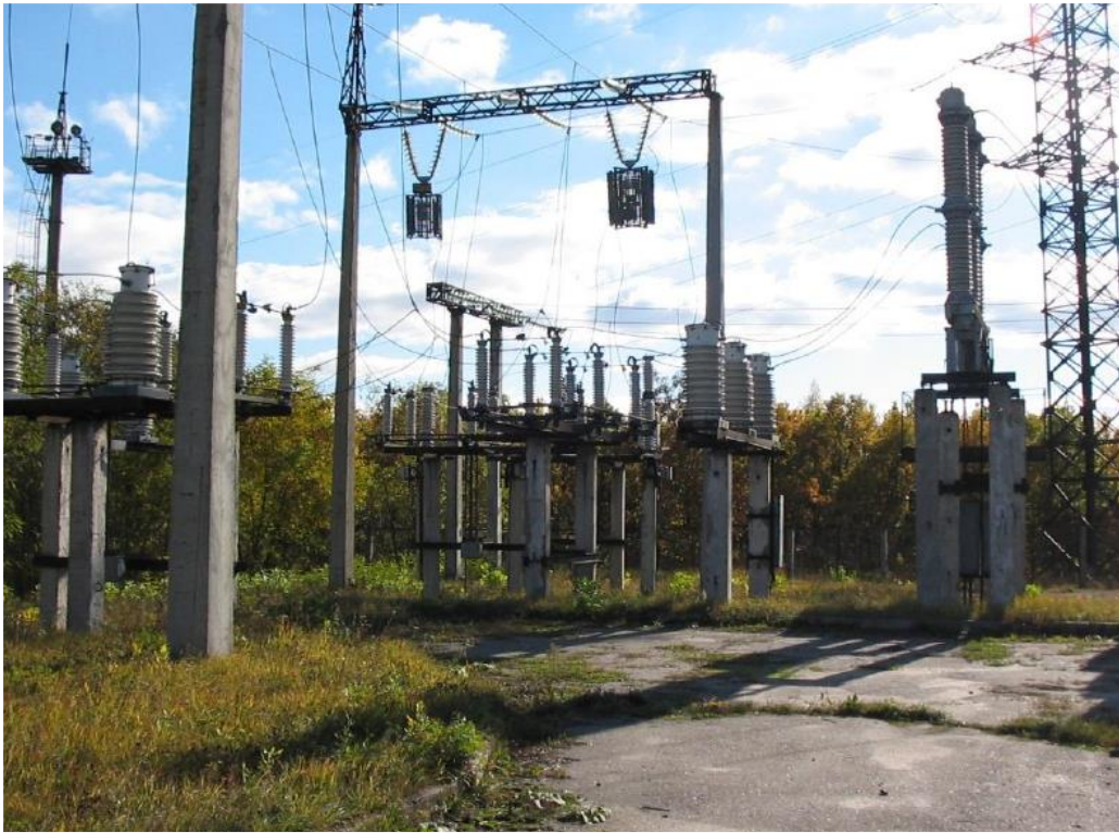
Рис. 11.10. Розподільний пристрій 110 кВ
