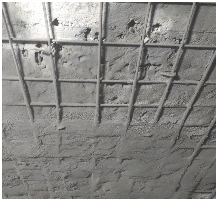
Рис. 1. Загальний вигляд поверхні при нанесенні шару торкретбетону
