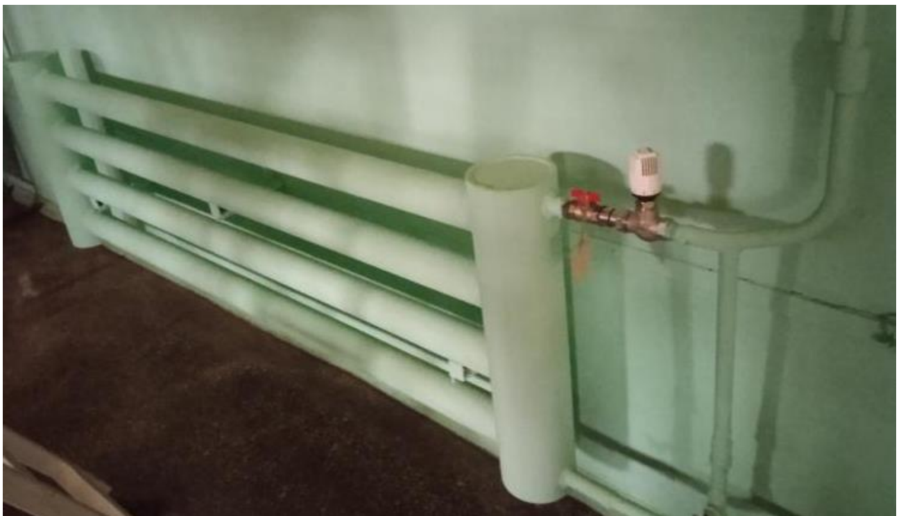
Рисунок 4.8 – Регістр системи опалення з термодіафрагмою і терморегулюючою ГОЛОВКОЮ
