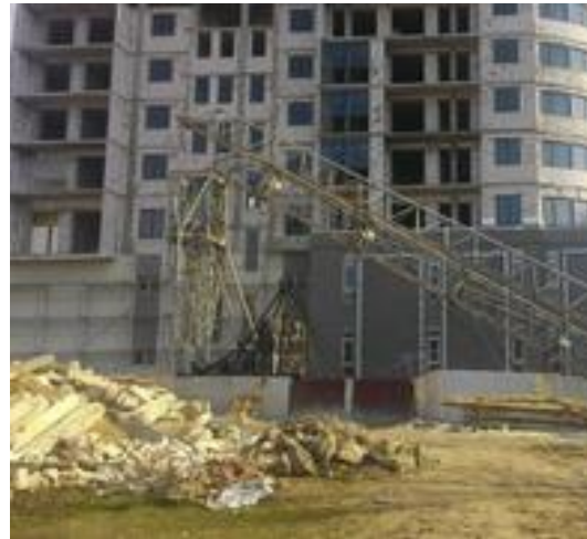
Рис. 1. Аварії баштових кранів із руйнуванням: стріли (м. Львів, 24.10.2024) і башти (м. Рівне, 16.03.2016)
