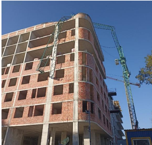
Рис. 1. Аварії баштових кранів із руйнуванням: стріли (м. Львів, 24.10.2024) і башти (м. Рівне, 16.03.2016)
