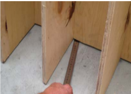
Рис. 15. Установлений зазор між перегородками і сферичною оболонкою
