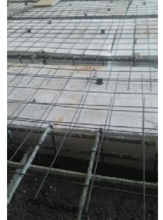
Рис. 21. Конструкція перекриття у процесі зведення
