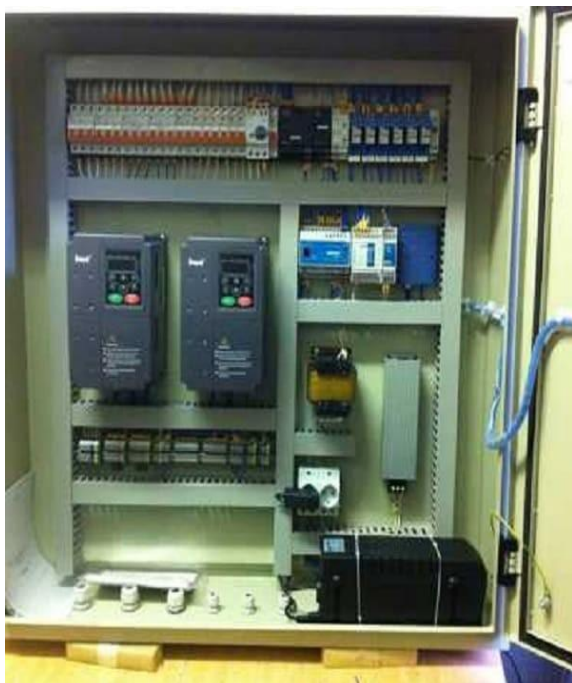
Рисунок 3.3 - Системи контролю та управління насосною станцією
