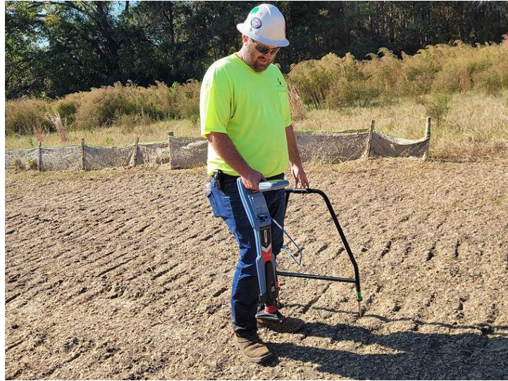
Рисунок 3.5 – Обстеження методом DCVG дефектів покриття трубопроводу
