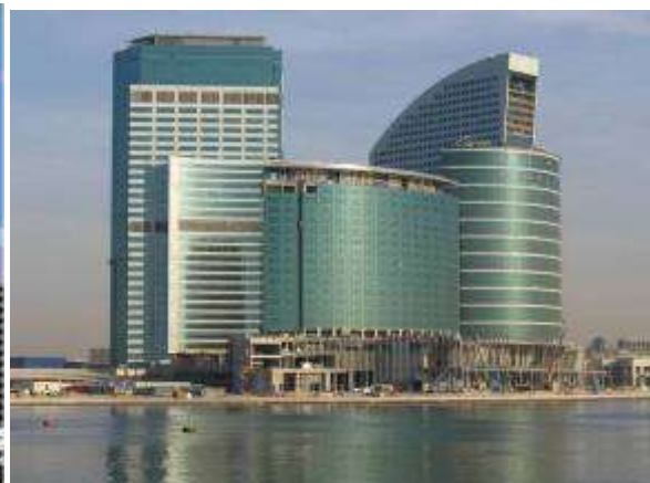
Рис.2. Застосування постнапруження за технологією фірми VSL. Дубай, ОАЕ (фестивальне містечко). Загальна площа постнапруження 250 тис.м 2
