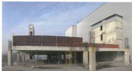
Рис.6. Випробування фрагменту перекриття другого поверху. Навантаження прикладається шляхом наповнення ємкостей водою. Вигляд збоку
