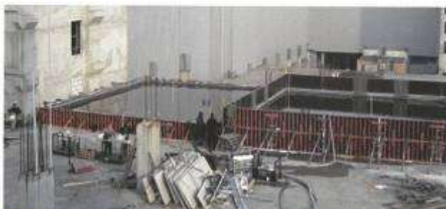
Рис.5. Випробування фрагменту перекриття другого поверху. Навантаження прикладається шляхом наповнення ємкостей водою. Вигляд зверху
