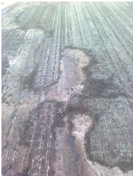
Рис.1. Фрезування зруйнованих і відшарованих асфальтобетонних шарів на неповну їх товщину
