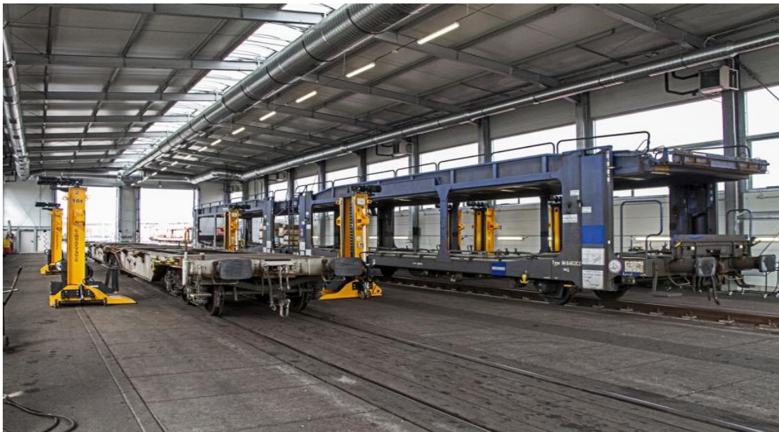
Рис. 1.4. Загальний вигляд сервісного ремонтного цеху для технічного обслуговування вагонів у європейській мережі
