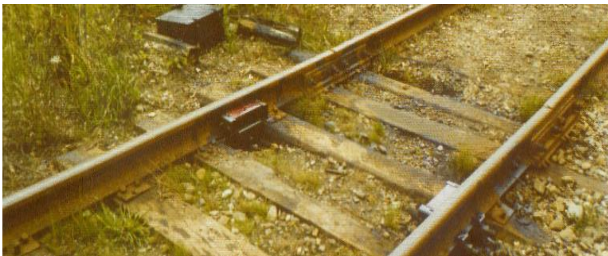
Рис. 13.2. Фото розташування точкового датчика системи ЕСЛО на колії
