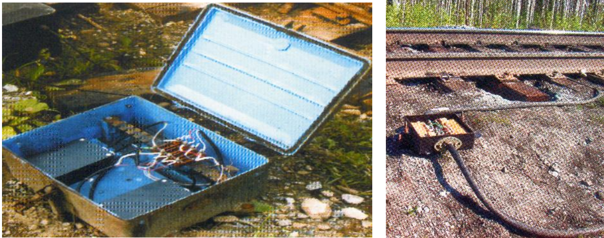
Рис. 13.3. Фото розташування підлогових пристроїв системи ЕСЛО в колійному ящику
