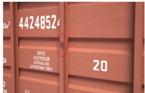
г) Тріщини і злами в стійці
