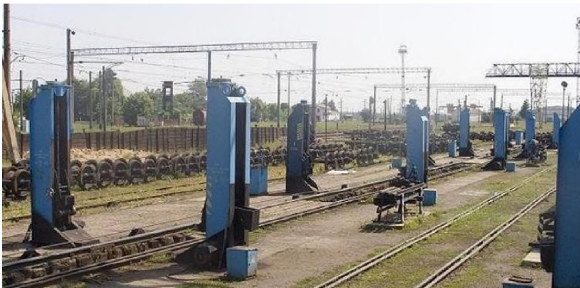
Рисунок 2.1 – Пункт перестановки пасажирських вагонів на станції [8]
