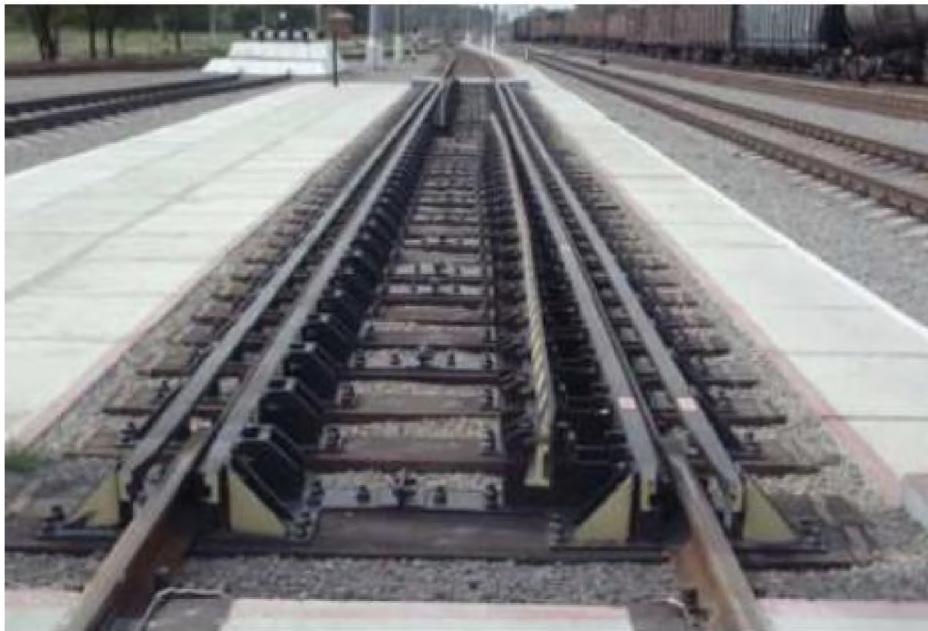
Рисунок 2.4 – Колієпровідний пристрій SUW 2000 [9]
