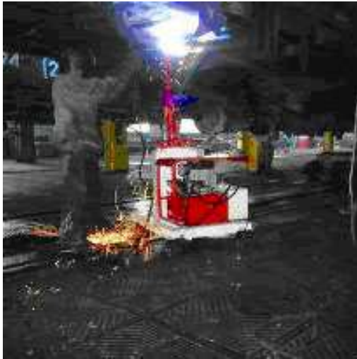
Рисунок 5.2 – Процес правки люків напіввагона
