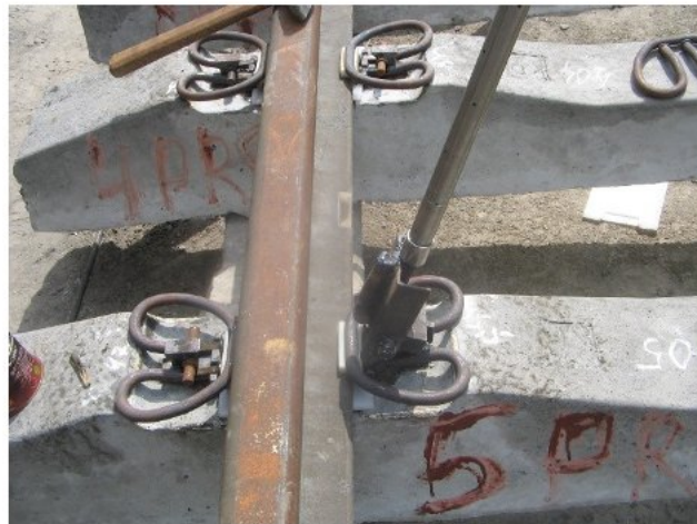
Рисунок 7.11 – Збирання ланки на шпалах Ш1-1-PRS:
