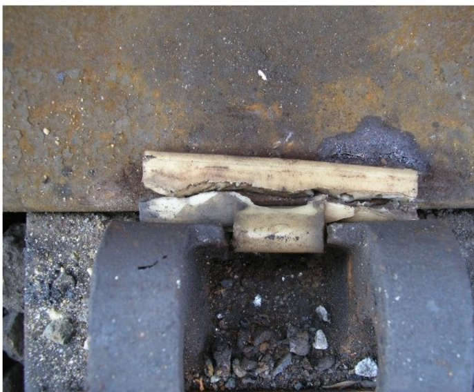
Рисунок 7.5 – Анкерне скріплення з високою поперечною жорсткістю АРС-4: а – деталь із з'єднаних скобою анкерів, зафіксована у формі перед формуванням шпал (Белгородський ЗЗБШ, Росія); б, в – характерні пошкодження – руйнування полімерних вкладишів на ділянці Іларионове – Синельникове Придніпровської залізниці
