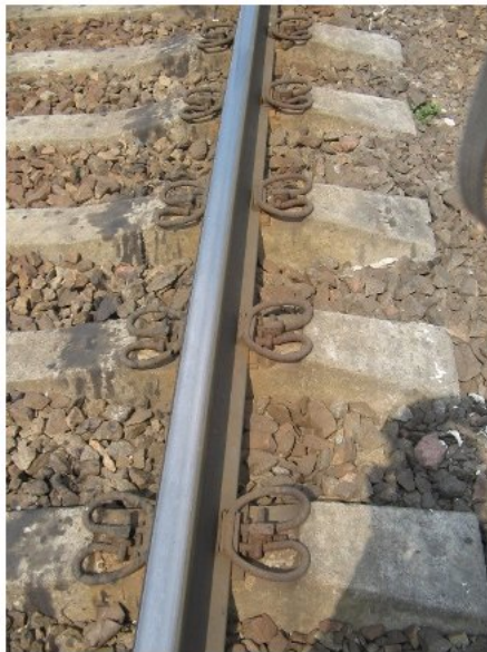
Рисунок 7.9 – Рейкові скріплення УС-1 в непарній колії 249 км ПК1 ділянки Основа - Букине Південної залізниці (між стрілочними переводами 550 і 572 станції Основа): а, б - через 9 років експлуатації (06.07.2011, ширина колії - 1518–1522 мм, перекіс - не більше 2 мм); в, г - через 12 років експлуатації
