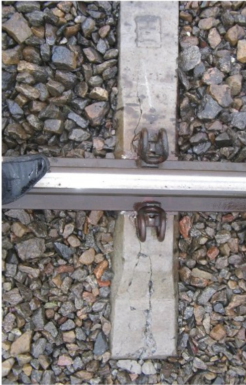
Рисунок 7.4 – Характерні пошкодження залізобетонних шпал зі скріпленнями з високою поперечною жорсткістю – подовжні тріщини від анкера до торця шпали: а, б – шпали СБЗ-1 зі скріпленням КПП-5; в – шпали зі скріпленням Vossloh W 14 (Литовська залізниця)
