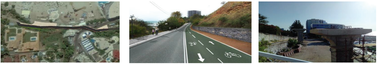
Рис. 2. Будівництво велопішохідної естакади на Трасі здоров'я (м. Одеса)
