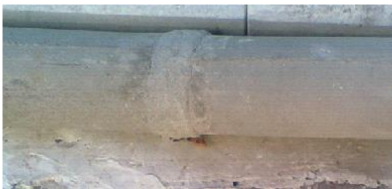
Рис. 15. Скріплення бетонної труби за допомогою рулонного композиційного матеріалу (бетонного «пластиру»)
