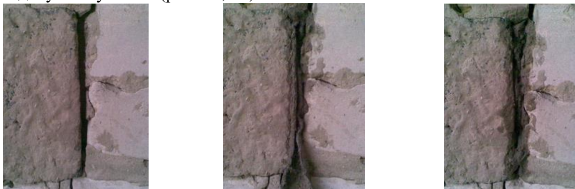
Рис. 14. Замонолічування тріщини в стіні за допомогою рулонного композиційного матеріалу (бетонного «пластиру»)
