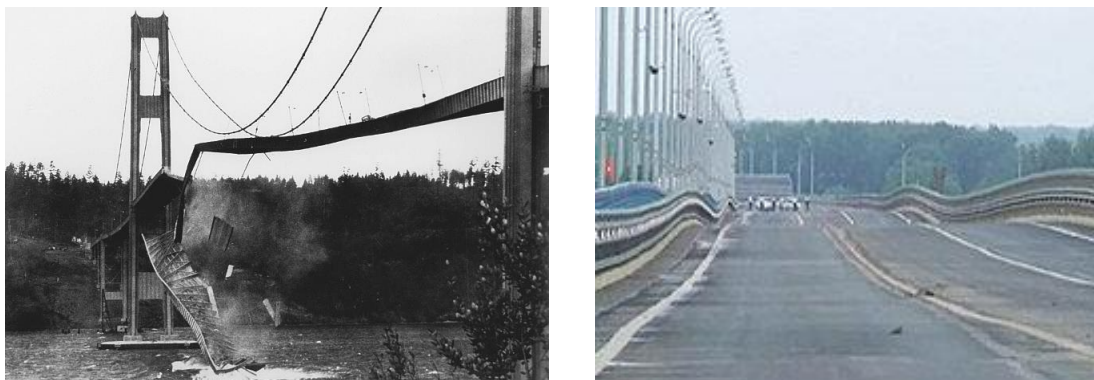
Рис. 4. Руйнування мостів: а) висячий Такомський міст (США, 1940 р.); б) Волгоградський хитний залізобетонний міст (Росія, 2010 р.)
