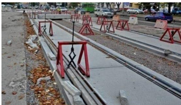
Рис. 8. Зведення трамвайної колії: а – зі збірною підрейковою основою із залізобетонних плит з ізольованими рейками (м. Харків, пр. Московський, 2016 р.); б – зі збірно-монолітною підрейковою основою із збірних залізобетонних блоків та монолітної плити (м. Харків, вул. Конєва, 2017 р.)
