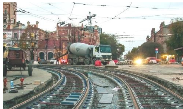
Рис. 8. Зведення трамвайної колії: а – зі збірною підрейковою основою із залізобетонних плит з ізольованими рейками (м. Харків, пр. Московський, 2016 р.); б – зі збірно-монолітною підрейковою основою із збірних залізобетонних блоків та монолітної плити (м. Харків, вул. Конєва, 2017 р.)
