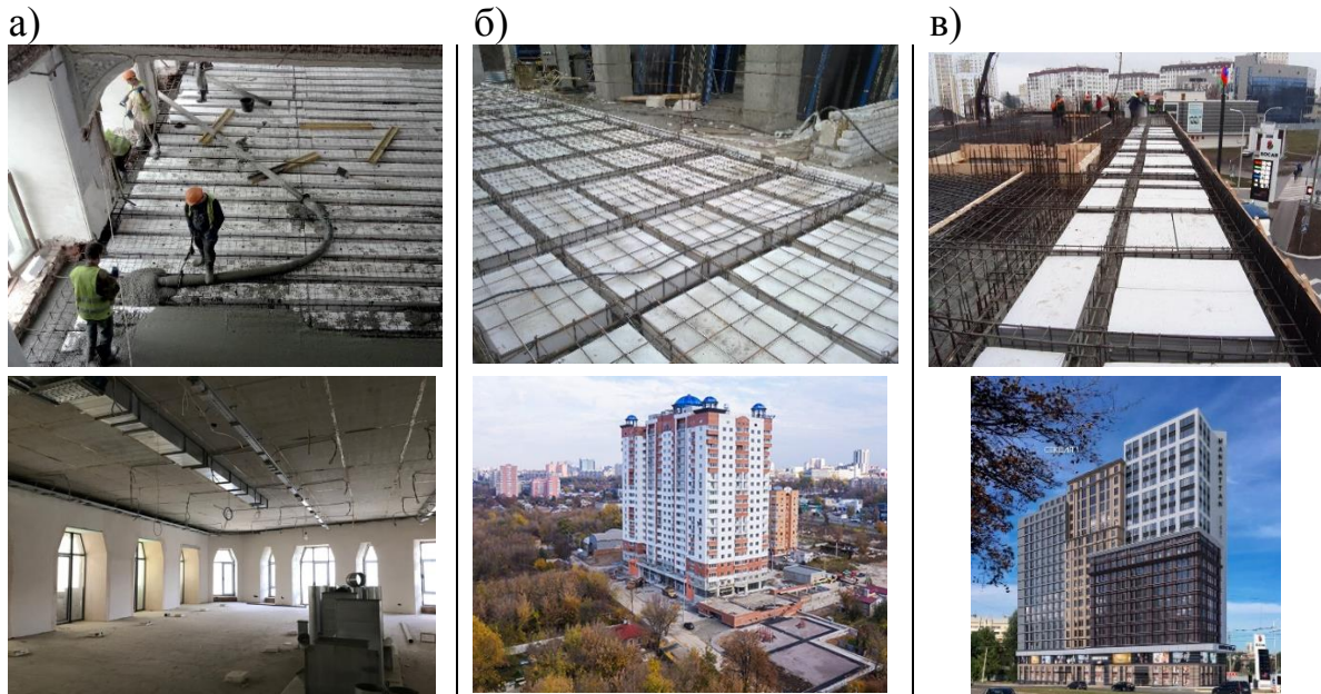
Рис. 17. Об'єкти впровадження: а) реабілітація нежитлової будівлі по майдану Павлівському, 4 в м. харкові – реставрація; б) Житловий комплекс «Будинок з ротондами» по вул.Сухумській, 11 в м. Харкові; в) Багатofункціональний комплекс «Манхеттен» по пр. Московському, 97 в м. Харкові
