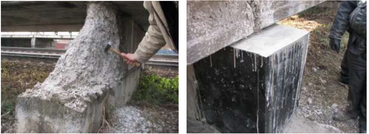
Рис. 13. Бетонна опора високої пасажирської платформи: а – стан опори до ремонту; б – відремонтована опора
