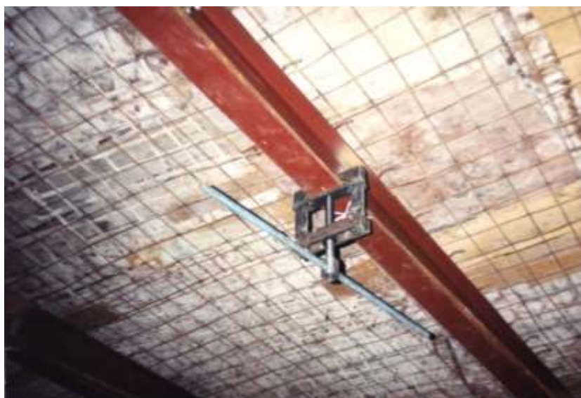
Рис.16 Подведение сталежелезобетонного локально предварительно напряженного перекрытия под существующее деревянное с использованием «набрызга» бетона
