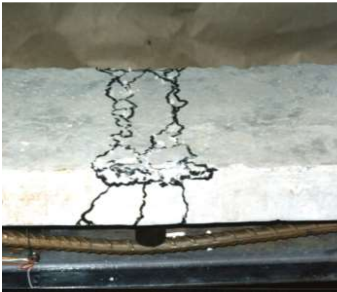
Рис.6. Характер разрушения и трещинообразования в железобетонной полке
