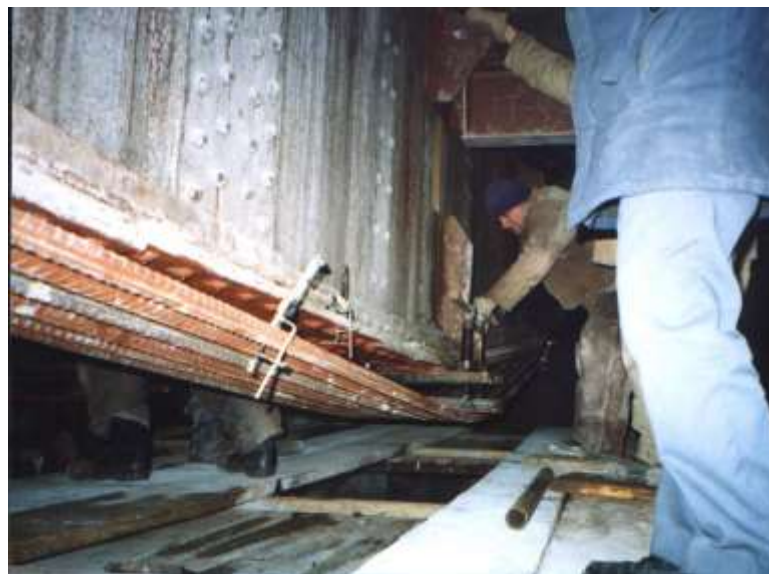
Рис. 15 Оттягивание напрягаемой арматуры ручными винтовыми домкратами с контролем деформаций тензодатчиками
