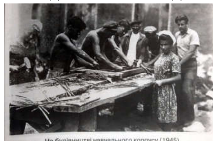
На будівництві навчального корпусу (1945).
