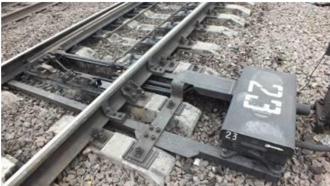
Рисунок 2.2 – Вістря гостряка з перевідним механізмом
