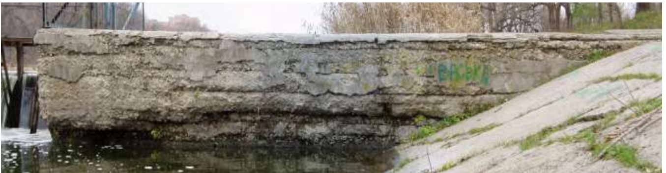
Рис. 3. Левобережный устой Лопанской плотины (вид с нижнего бьефа)
